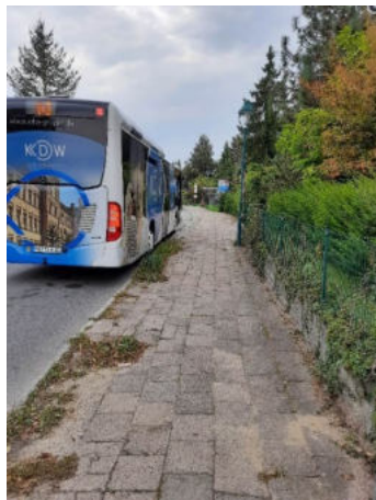
Abbildung 18: Gehweg Haltestelle Alexanderplatz
