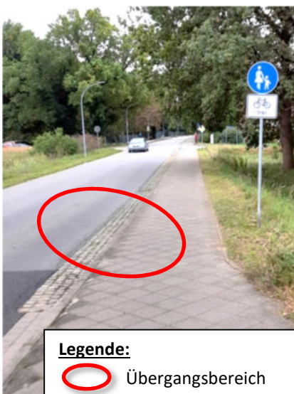
Abbildung 49: fehlender Übergang Carl-Meier-Str.
