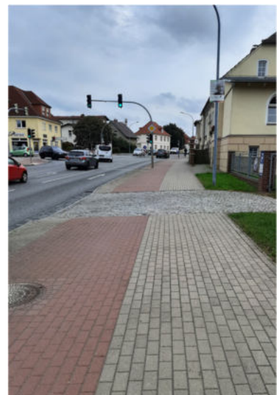
Abbildung 1: Zufahrt mit groben Naturpflaster Strelitzer Chaussee
