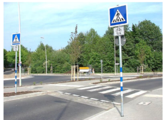
Abbildung 8: Beispiel eines Fußgängerüberweges
