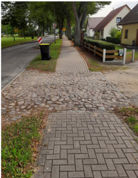
Abbildung 5: Bsp. Zufahrt Rudower Straße
