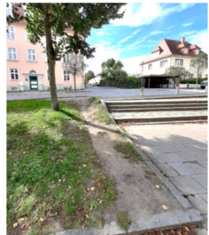
Abbildung 24: Abgefahrene Grasfläche an Treppe Carlstr.
