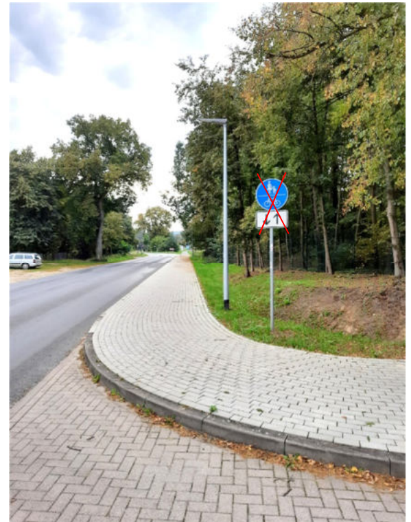
Abbildung 62: Rückbau der Benutzungspflicht
