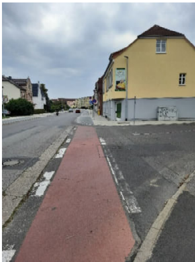
Abbildung 13: Abgefahrene Markierung Wilhelm-Stolte-Straße/Bahnhofstraße
