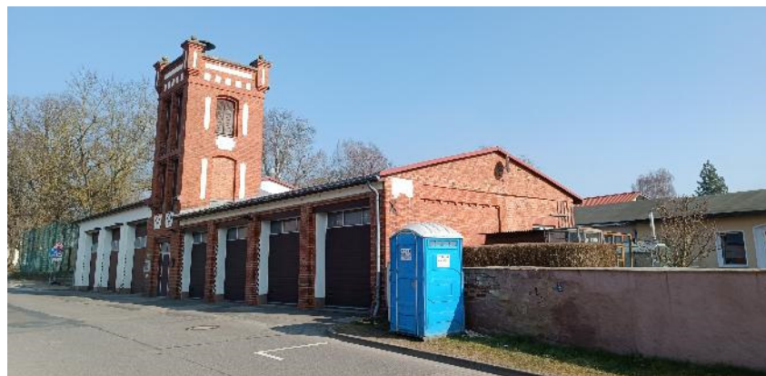
Abbildung 16: Ehemaliges Feuerwehrgebäude (eigene Aufnahme, 2025)
