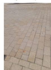
Pflasterung Fahrbahn: Großpflaster / Reihenverband
