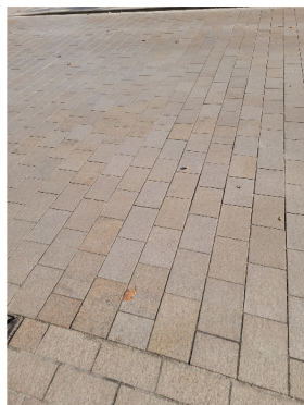
Pflasterung Fahrbahn Großpflaster Reihenverband
